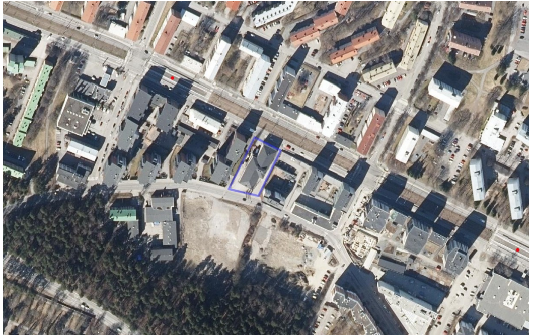
Kuva 12. Suunnittelualueen sijainti ilmakuvassa esitettyä. Tontti sijaitsee tiiviisti rakennetussa kaupunkiympäristössä.
